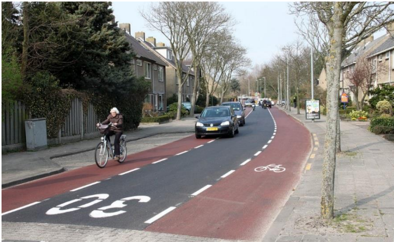
شکل ۲۳: تصویری از یک خط دوچرخه ترجیحی - ترجیحی احتمالاً ترجمه مناسبی برای این کلمه نیست ولی نتوانستم معادل بهتری بیابم. همان طور که در این تصویر دیده می‌شود، خط دوچرخه، در واقع در دل خط خودرو قرار دارد و ماشین‌ها از روی آن عبور می‌کنند. فقط باید حواسشان به حضور دوچرخه‌سواران باشد.
