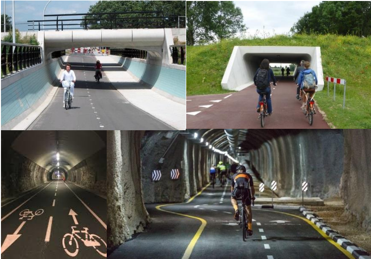
شکل ۳۰: نمونه‌هایی از زیرگذرها و تونل‌های ویژه عبور دوچرخه در شبکه‌های دوچرخه‌سواری شهری برای جلوگیری از تقابل دوچرخه‌ها با ترافیک خودرویی
