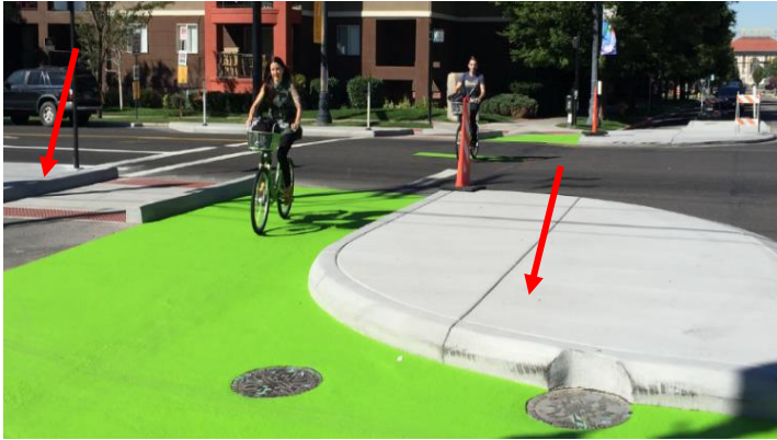
شکل ۲۹: استفاده از جزایر ترافیکی در یک تقاطع برای تأمین امنیت بیشتر مسیر دوچرخه‌سواری - این سکوهایی که برای جهت‌دهی به ترافیک در میان مسیرها ایجاد می‌شوند را اصطلاحاً جزایر ترافیکی می‌گویند.
